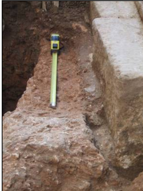
Fotografia 39: Rasa de fonamentació de la torre 22.
