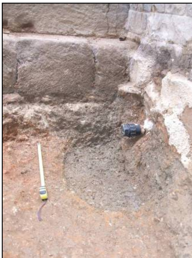
Fotografia 34: Sitja SJ-108, al costat de la base de la torre 21 abans de l'excavació.
