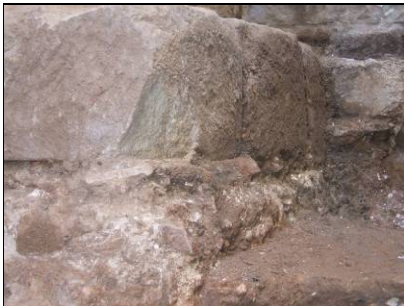
Fotografia 36: Sustentació dels carreus rectangulars a la base de la torre 21, format per morter de calç, tegulae i pedres més petites.
