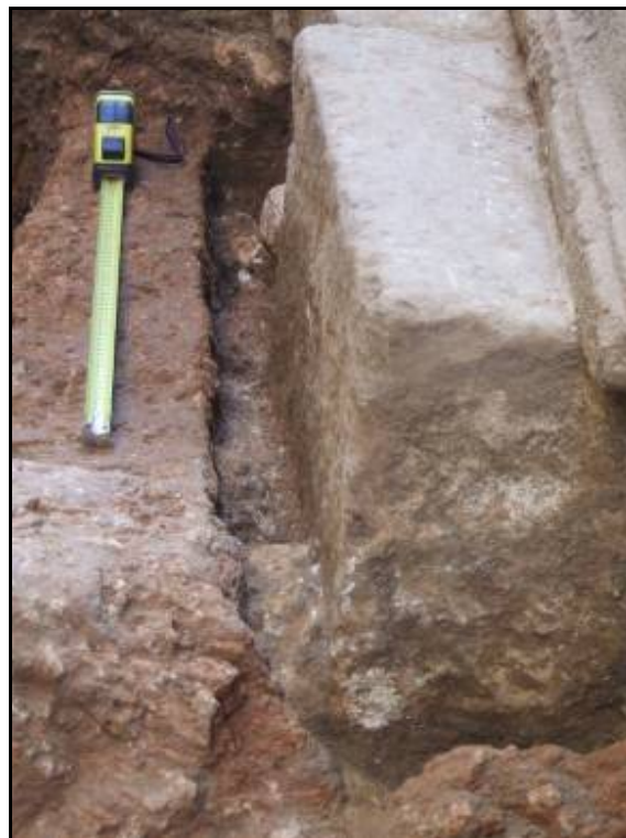
Fotografia 40: Rasa de fonamentació de la torre 22 durant el procés de buidament.
