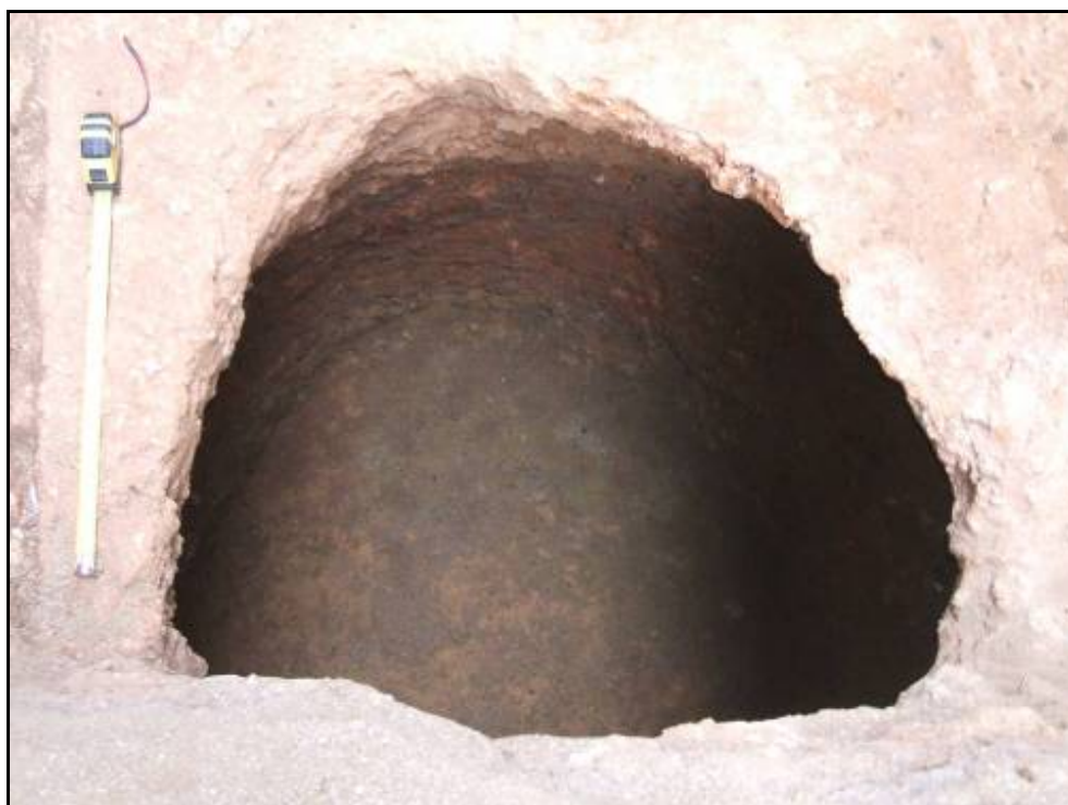
Fotografia 28: Sitja SJ-102, final d'excavació.
